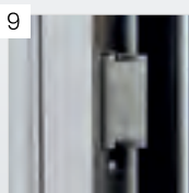
9 Zasuwnica GU rygiel automatyczny podstawowy
