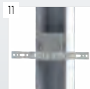
11 Elementy wzmacniające konstrukcję ościeżnicy z kotwami montażowymi
